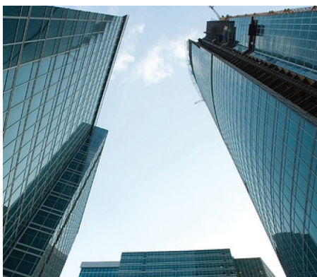
Жилищное и коммерческое строительство
