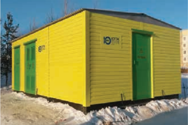
ОАО «ЮТЭК-Региональные сети», г. Покачи
